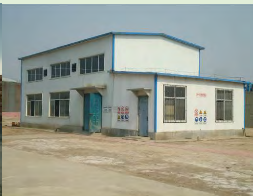
图 5-7 滨一废液处理站
