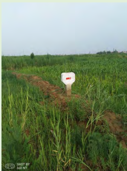
图 3-4 集油管线标志桩照片
